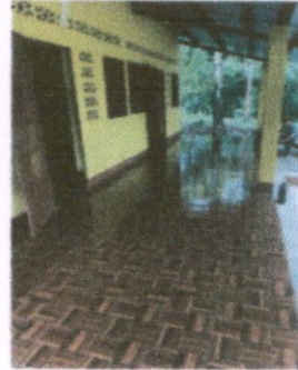
Foto 2: Reparacion en piso ceramico en modulo 1 y corredor
